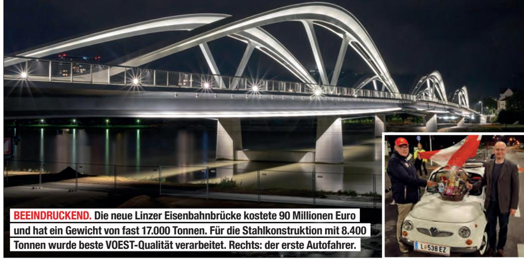
**BEEINDRUCKEND.** Die neue Linzer Eisenbahnbrücke kostete 90 Millionen Euro und hat ein Gewicht von fast 17.000 Tonnen. Für die Stahlkonstruktion mit 8.400 Tonnen wurde beste VOEST-Qualität verarbeitet. Rechts: der erste Autofahrer.
