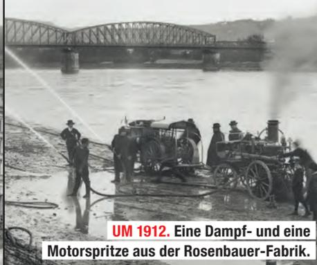
**UM 1912.** Eine Dampf- und eine Motorspritze aus der Rosenbauer-Fabrik.
