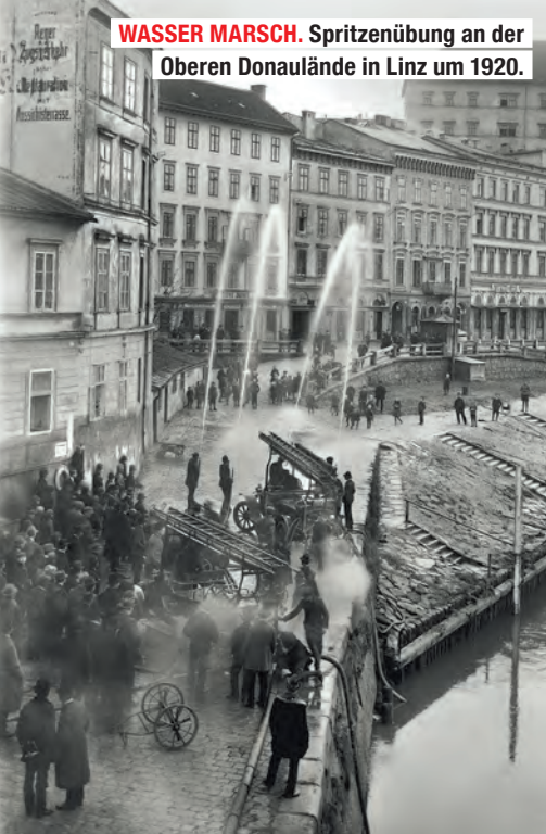
UNTER DAMPF. Die Dampffeuerspritze schaffte 800-900 l/min bei 48 m Wurfweite.
