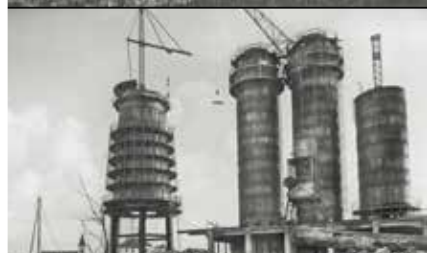
ENDE 1938. Die Winderhitzer des Hochofens 1 sind bereits erkennbar.
