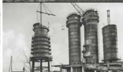
ENDE 1938. Die Winderhitzer des Hochofens 1 sind bereits erkennbar.
