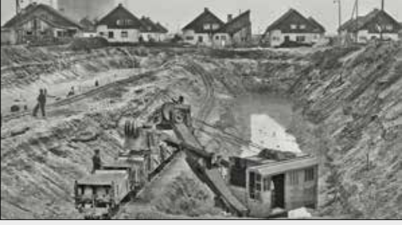
FEUCHTE GRUBE STATT WARMER STUBE. Hinter der Baugrube von 1940 sind die letzten verbliebenen Häuser der Ing.-Demant-Siedlung zu sehen.
