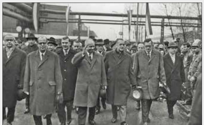
WIRTSCHAFTSDELEGATION. Werksbesichtigung in der VÖEST. Ein Jahr zuvor ging im indischen Rourkela erstmals ein LD-Stahlwerk im Ausland in Betrieb. Entsprechend groß war das Interesse der UdSSR.
